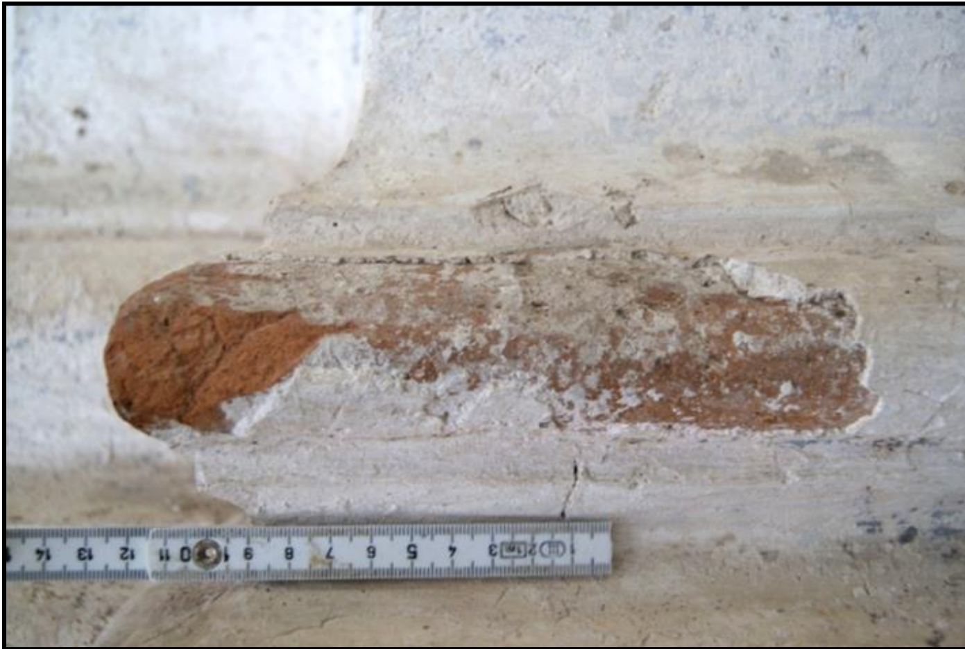
Cavallasca, Oratorio S. Carlo degli Imbonati, Agostino Silva, 1669-75, Shaped brick of the pilaster base
